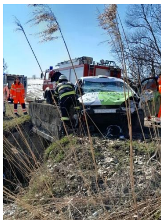
Fig. 3.5: Capul de podeț prezent pe traseul probei nu a fost semnalizat și protejat corespunzător cu dispozitive sau materiale pentru absorbția energiei de impact. 15
